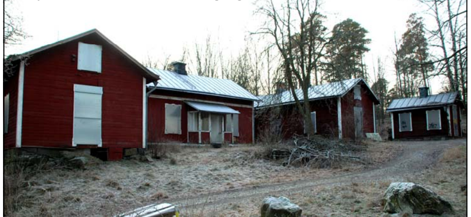
Fanjunkarbostället slitet och nedgången december 2008
